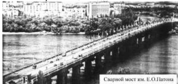
Рис.4. Уникальное сооружение среди цельносварных мостов мира - автомобильный мост имени Е.О. Патона через Днепр в г. Киеве. Длина моста 1542 м, общая масса - 10 тыс. т, 20 пролётов по 58 м и 4 судоходных пролёта по 87 м
