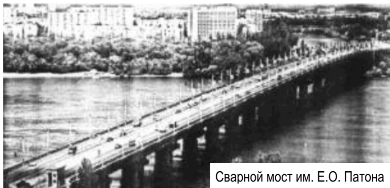
Рис. 4. Уникальное сооружение среди цельносварных мостов мира – автомобильный мост имени Е.О. Патона через Днепр в г. Киеве. Длина моста 1542 м, масса – 10 тыс. т, 20 пролётов – по 58 м и 4 пролёта – по 87 м
